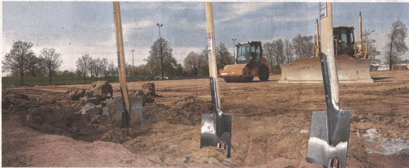
Mit dem obligatorischen Spatenstich begannen gestern offiziell die Arbeiten für zwei Kunstrasenplätze im Weierhausstadion.
